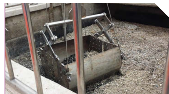
Czerpak do czyszczenia zbiorników z kożucha i części pływających
